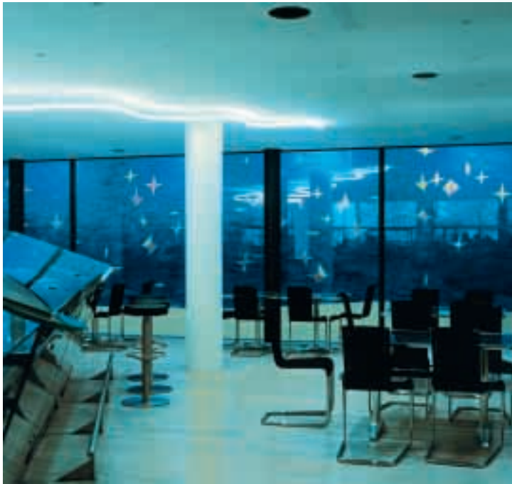
I soffitti in lastre Knauf Forate e Fessurate sono accoppiati con un feltro fonoassorbente nero o bianco.
