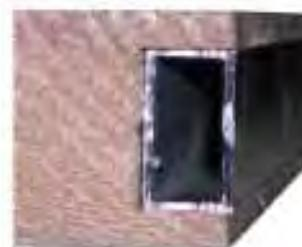
Sezione del massello verticale di rinforzo con all'interno tubolare in alluminio.
