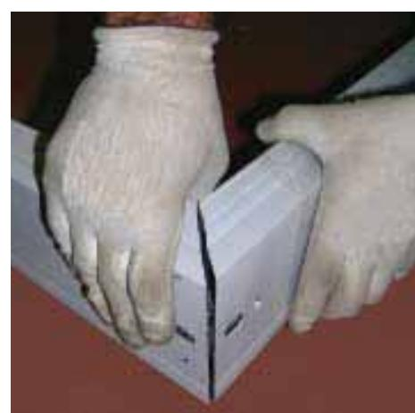
Particolari del montaggio degli angoli | Details of the mounting of the corners | Особенности монтажа углов
